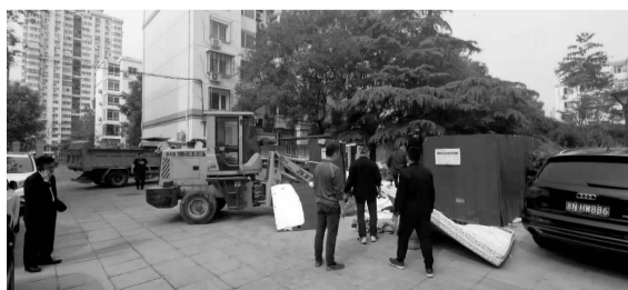
工作人员对大件垃圾投放点进行拆除
